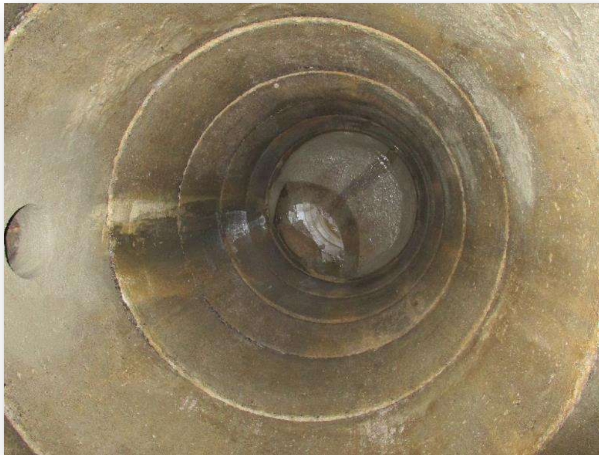
Nettoyage du regard
