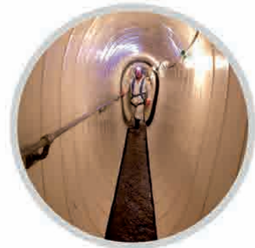
Réhabilitation des ouvrages visitables
