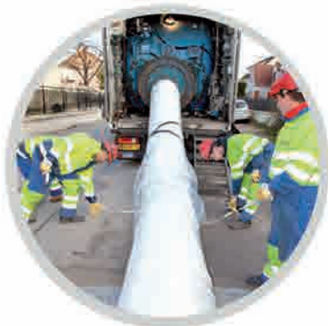
Réhabilitation des collecteurs non visitables
