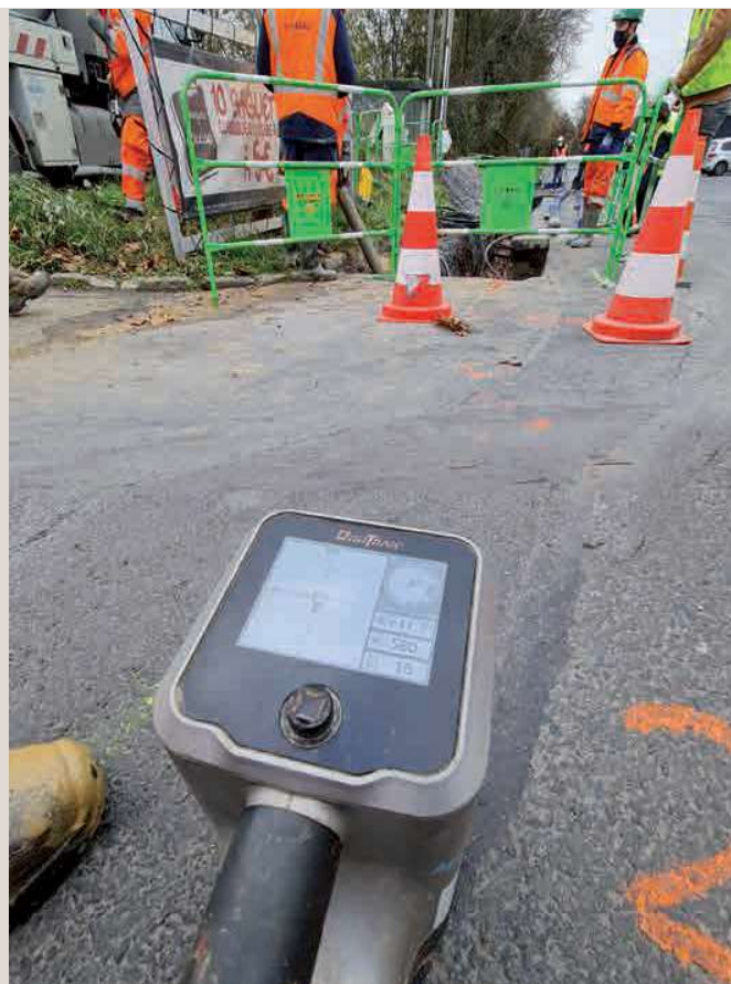
Le cheminement de la tête de forage est suivi de très près en surface avec un détecteur électromagnétique.
