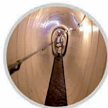
Réhabilitation des ouvrages visitables
