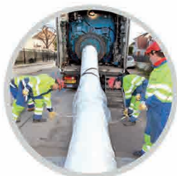
Réhabilitation des collecteurs non visitables
